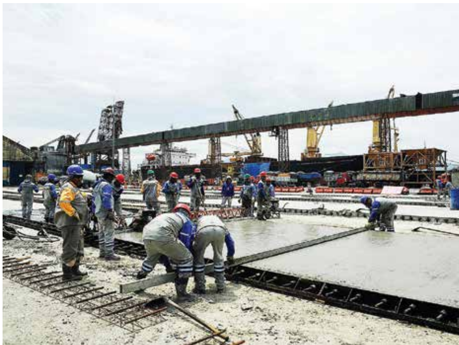
Novos Investimentos - concretagem nos Pátios dos antigos
