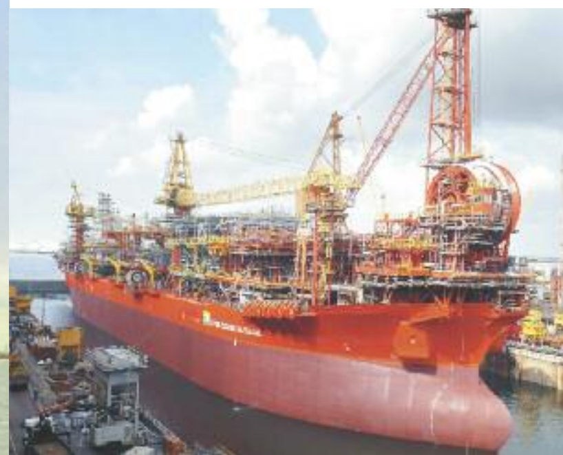
Abaixo, o FPSO Cidade de Itajaí, em Cingapura, antes do incêndio
