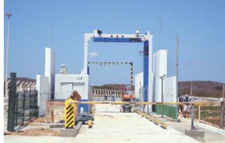
Posto fiscal de Tianguá: scanner fixo na via terrestre que leva a Pecém
