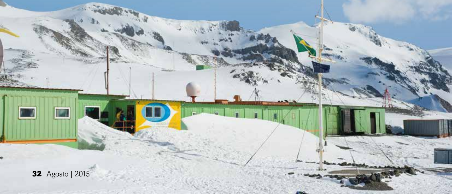
Módulos, tipo contêineres, da estação Comandante Ferraz
